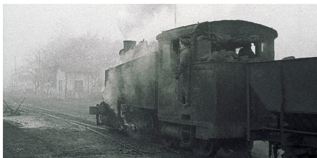
Una vez llegadas las Krauss, las Baldwin se ocuparon cada vez más de las maniobras en las instalaciones de Ponferrada y ramales de la línea. Ed Kaas.
