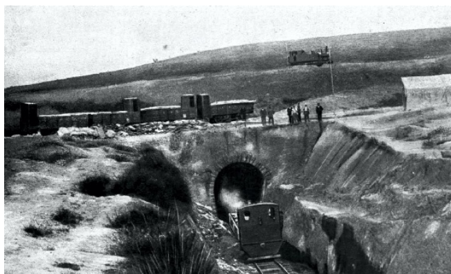
Túnel en el P.K. 11, cerca de la central térmica Compostilla II. Las dificultades para su terminación obligaron a una variante para continuar las obras. Diego González Ragel/MSP.
